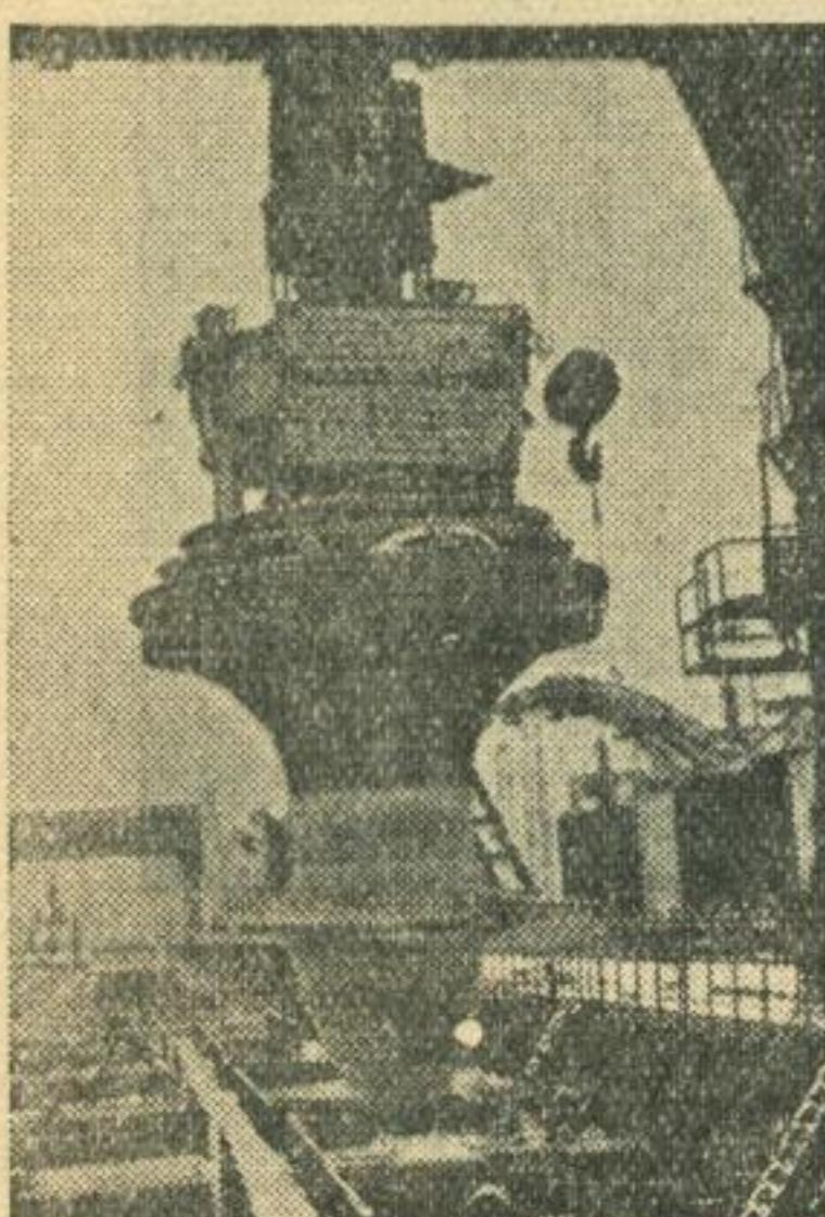
На снимке, привезенном со строительства ГЭС, запечатлен момент установки 23-й турбины Камской ГЭС. Это — последняя турбина. В канун Нового года она вступила в строй, и Камская гидроэлектростанция достигла своей проектной мощности. В ушедшем в историю 1956 году завод изготовил для Камской ГЭС 4 турбины, для Кайрак-Кумской — 2 и другое гидротехническое оборудование.
